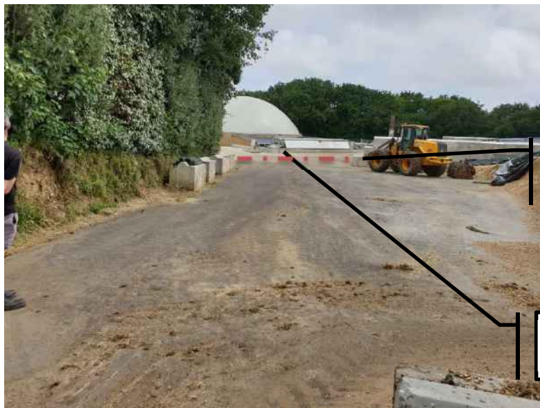
Zone de confinement bétonnée côté haut silos
