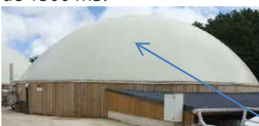
Gazomètre digesteur
