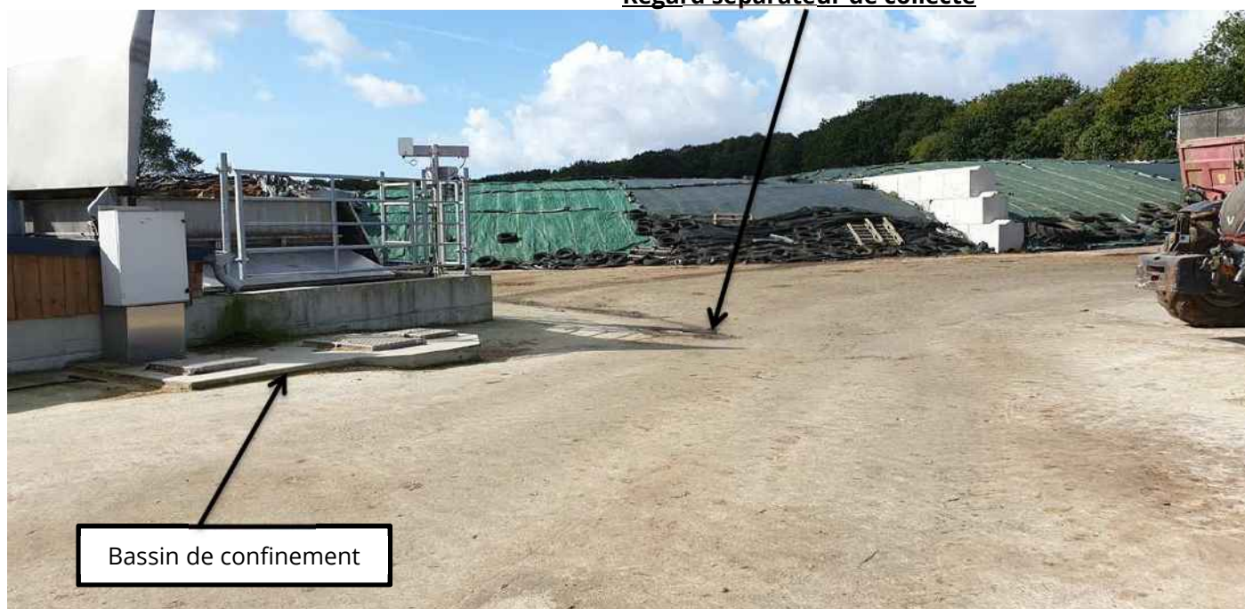
Regard séparateur de collecte
